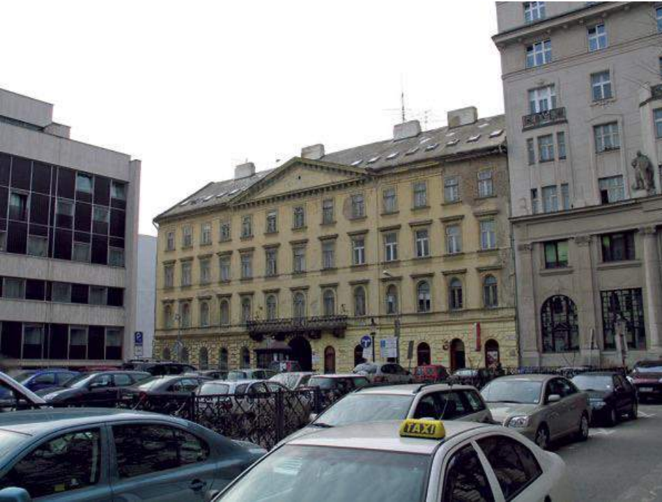
Bratislava, palác Motešických pred rekonštrukciou / nadstavbou (2008-10)
